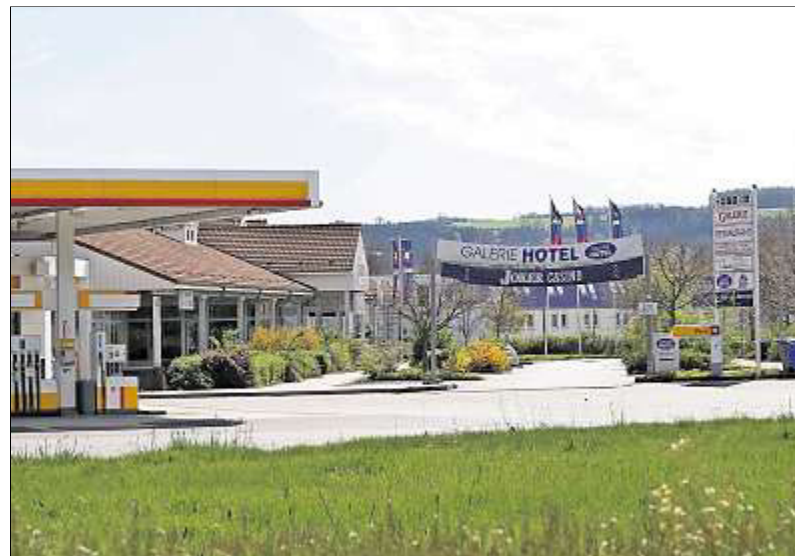
Seit fast einem Jahr ist die Autobahngalerie in Himmelkron schon geschlossen.
